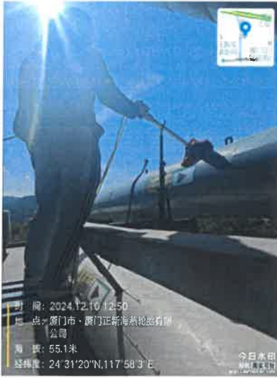
RTO 炉废气排放口
