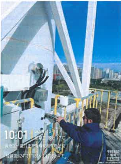
501 混炼车间排气筒出口 (DA003)
