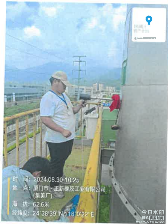
105A 硫化车间排气筒出口 (DA005)
