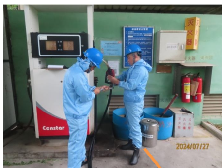
对泄漏管路拆卸维修
