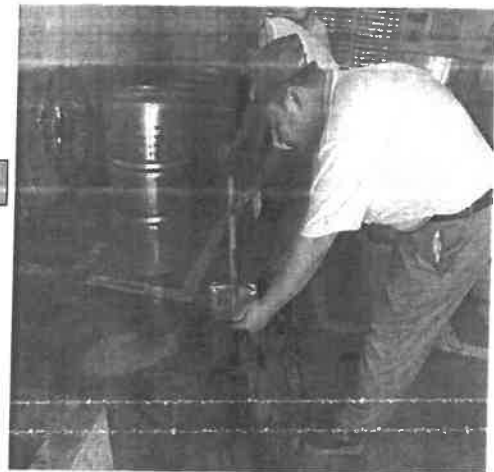
9. 安排人员对现场清理
