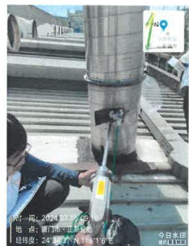
303 车间硫化车间排气筒出口 DA047 (19 号排气筒)
