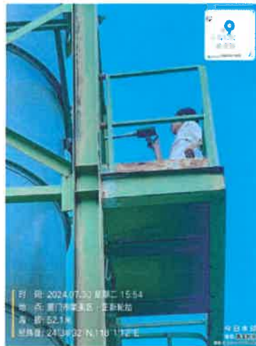
703 车间硫化车间排气筒出口 DA051 (31 号排气筒)
