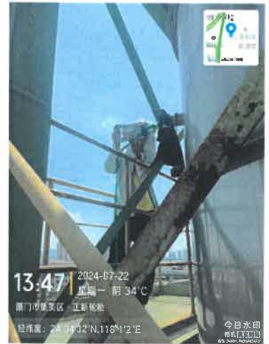
203 车间硫化车间 排气筒出口 DA036 (26 号排气筒)
