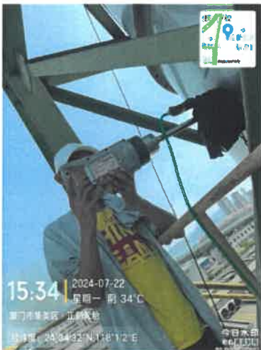
203 车间硫化车间排气筒出口 DA034 (27 号排气筒)
