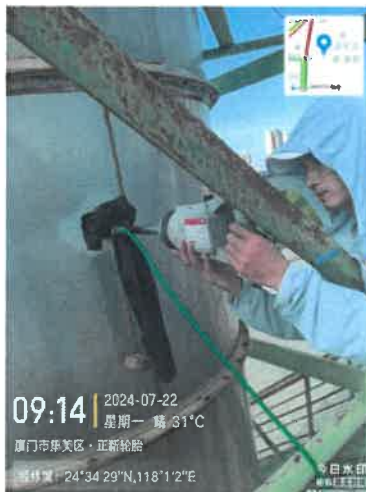
203 车间硫化车间排气筒出口 DA053 (28 号排气筒)
