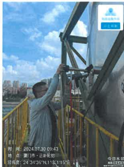
301/501 炼胶车间排气筒出口 DA013 (2号排气筒)
