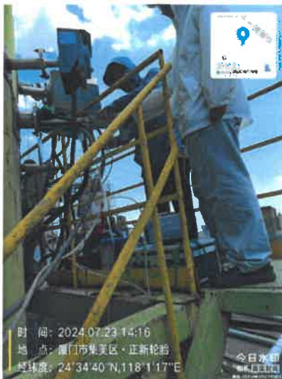
03 炼胶车间排气筒出口 DA001 (1号排气筒)
