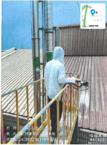
208 检修车间排气筒出口 DA025 (55 号排气筒)
