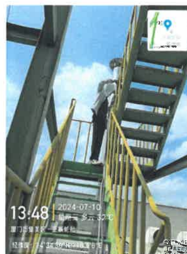
503 硫化洗模车间排气筒 出口 DA066 (66 号排气筒)
