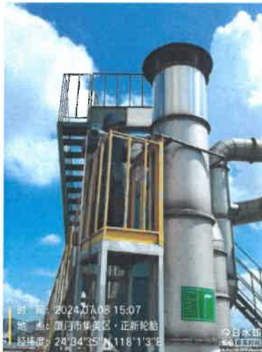
504 检修车间排气筒出口 DA018 (46 号排气筒)
