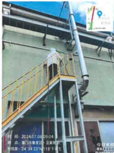
704 检修车间排气筒出口 DA020 (47 号排气筒)
