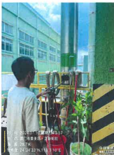
502 检修车间排气筒出口 DA022 (49 号排气筒)
