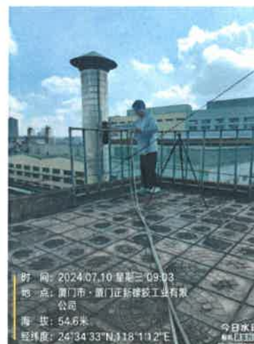
703 成型车间排气筒出口 DA006 (40 号排气筒)
