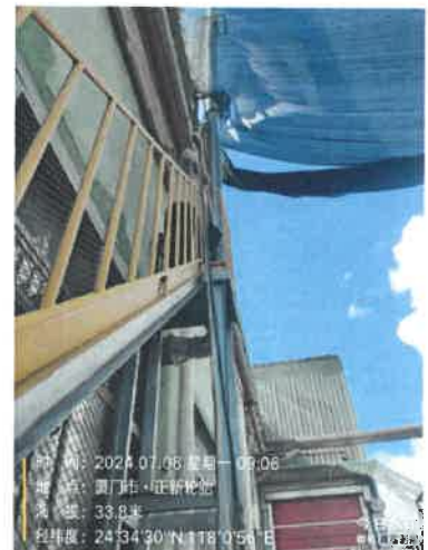
203 检修车间排气筒出口 DA021 (48 号排气筒)
