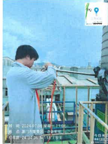
302 成型车间排气筒出口 DA010 (37 号排气筒)
