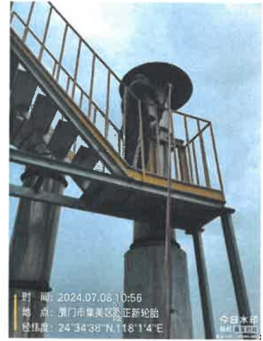
304 检修车间排气筒出口 DA019 (45 号排气筒)
