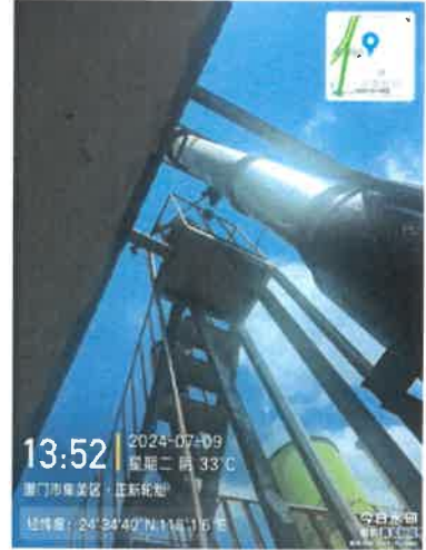
04 成型车间排气筒出口 DA008 (35 号排气筒)
