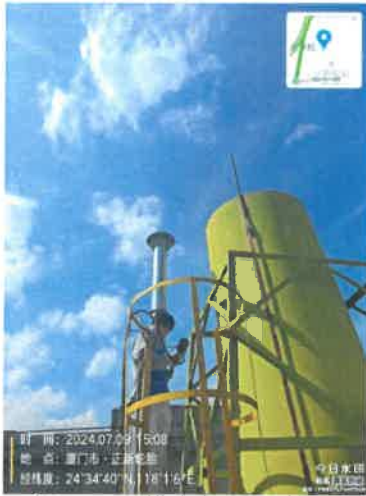
05 硫化洗模车间排气筒出口 DA062 (62 号排气筒)
