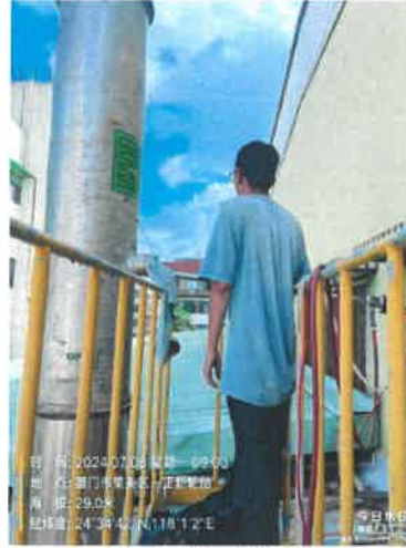
02 检修车间排气筒出口 DA016 (43 号排气筒)
