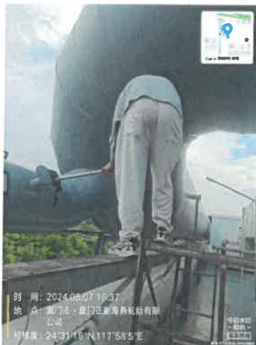
RTO 炉废气排放口
