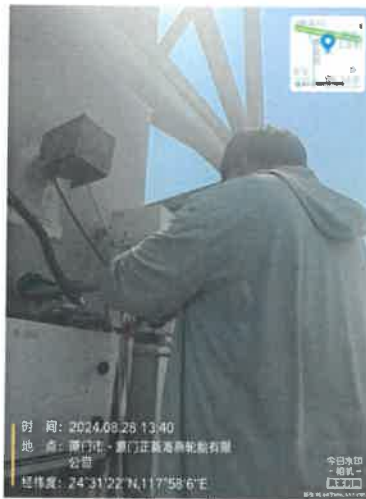
101 混炼车间排气筒出口 (DA001)
