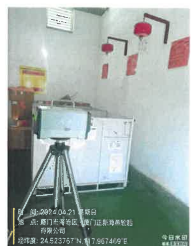
危废仓库 TS003 内
