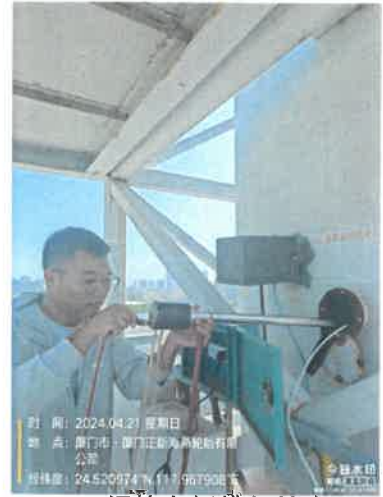
301 混炼车间排气筒出口 (DA002)
