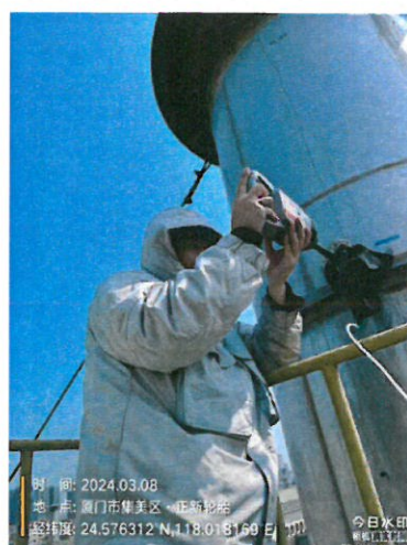
503 车间硫化车间排气筒出口 DA050 (厂内编号 DA022)
