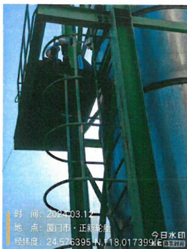
504 车间硫化车间排气筒出口 DA028 (厂内编号 DA024)
