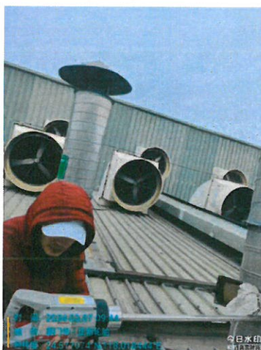
303 车间硫化车间排气筒出口 DA042 (厂内编号 DA012)
