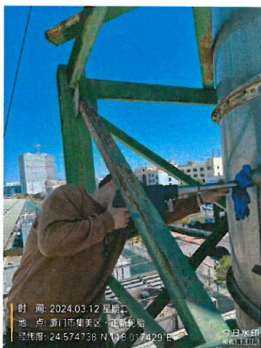
203 车间硫化车间排气筒出口 DA053 (厂内编号 DA028)
