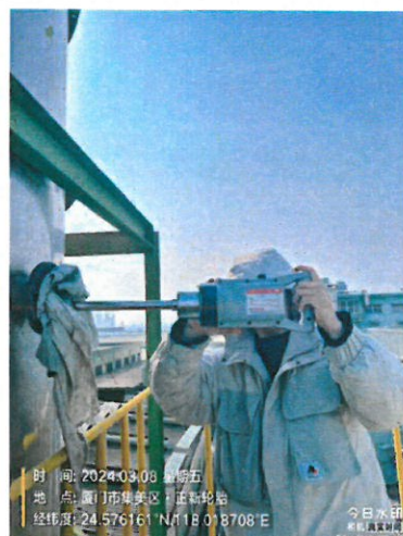
306 车间硫化车间排气筒出口 DA044 (厂内编号 DA030)
