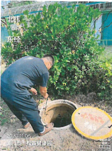
废水站总排口 (DW001)
