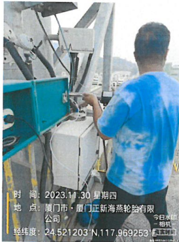
101 混炼车间排气筒出口 (DA001)
