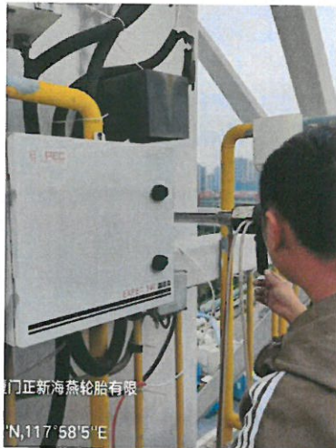
501 混炼车间排气筒出口 (DA003)
